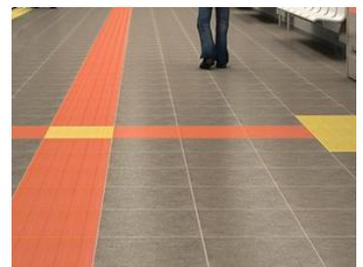
Уличные плитки монтируются в тротуар таким образом, чтобы они не являлись препятствием для пешеходов. Внутри помещений используют как встраиваемые, так и наклеиваемые на половое покрытие плитки или отдельные тактильные элементы.
